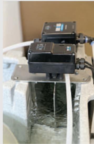
Schwerkraftversion mit automatischer Wehrplatte
